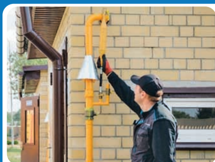
Приспособление для удаления ледяных закупорок
