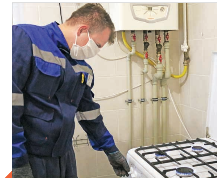
Проверка газового оборудования у абонента
