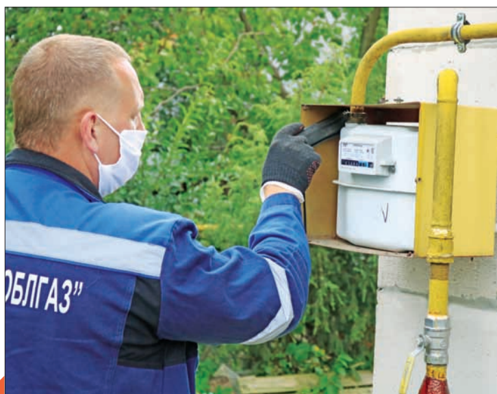
Проверка счетчика газоанализатором
