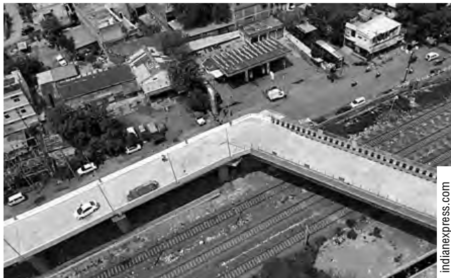
Прямоугольный путепровод в городе Бхопале быстро стал местной достопримечательностью
