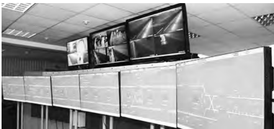
Современные мониторы, внедренные в автоматизированную систему диспетчерского управления движением поездов
