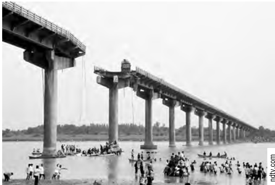
Мост Гамбхира сразу после обрушения пролета
