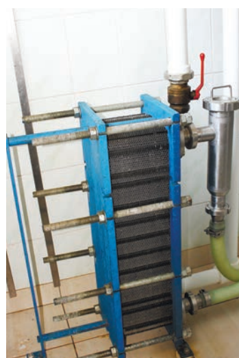
Теплообменный аппарат
