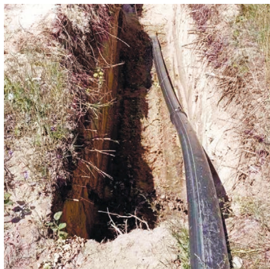
Фото с места прокладки газопровода в Луинецком районе
