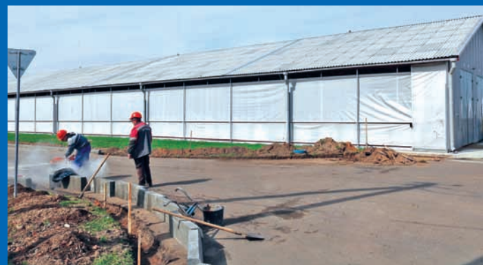
Работы по благоустройству на МТФ «Доманово»
