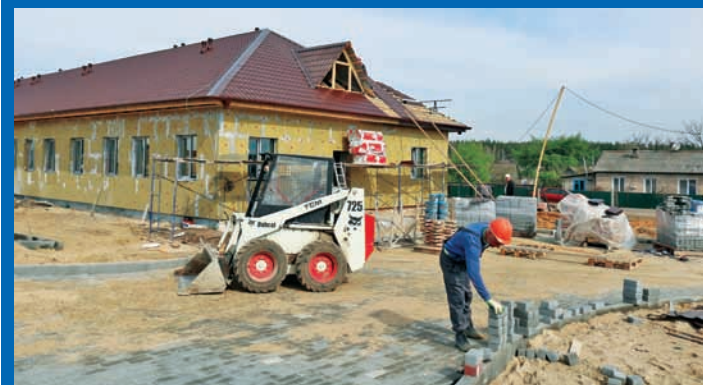
Реконструкция административно-бытового корпуса
