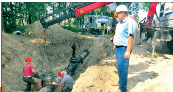
Проведение работ по замене задвижки Ø300 мм на газопроводе высокого давления 1-й категории Ø325 мм по ул. Пушкина в г. Пружаны
