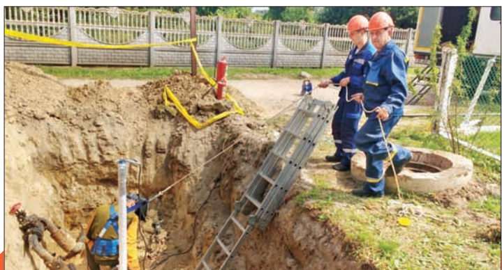
Проведение работ по замене задвижки Ø80 мм на газопроводе среднего давления Ø89 мм по ул. Центральная в аг. Остромичи Кобринского района
